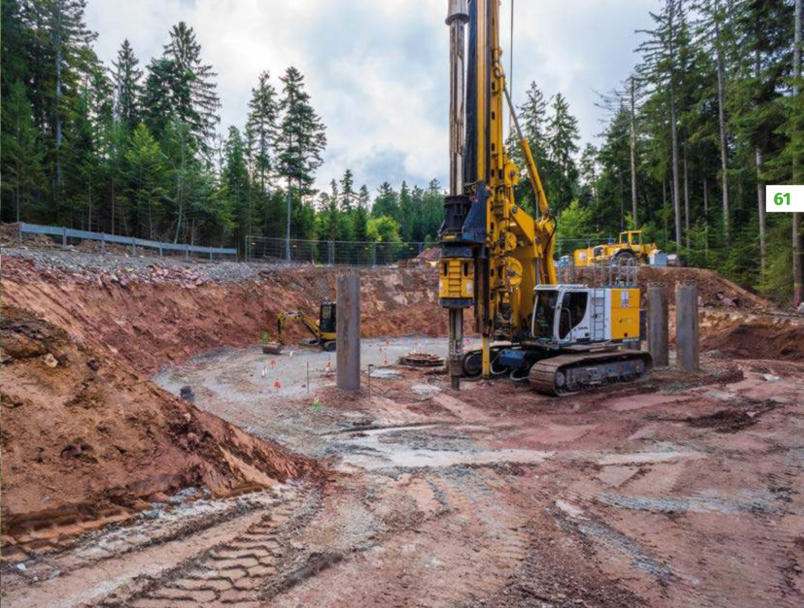
Gewaltige Beton-Fundamente, rund 15 m tief, müssen für diese Anlagen in die Erde getrieben werden - Foto: Joachim Wasserthal
