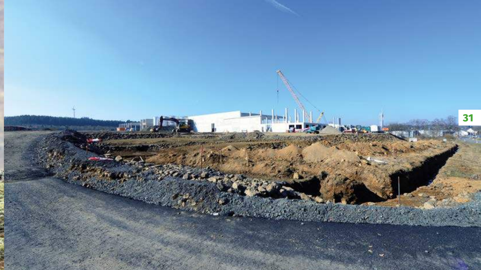
Fortschreitende Flächenversiegelung für Bau- und Gewerbegebiete
